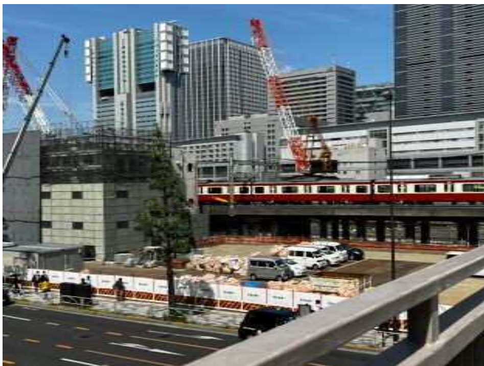
品川駅の工事の様子
