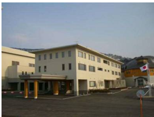
田沢湖スポーツセンター外観
